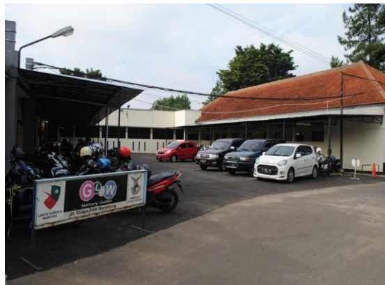
Penataan Lapangan Parkir
